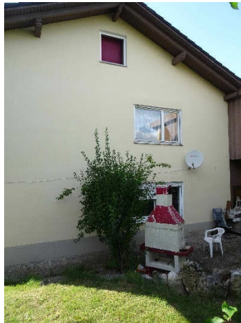
Bild 7: IO Fl.Nr. 626/8 zum Bauunternehmen
