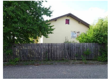
Bild 5: IO Fl.Nr. 626/8 zum Bauunternehmen
