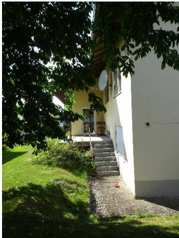
Bild 6: IO Fl.Nr. 626/8 zum Bauunternehmen
