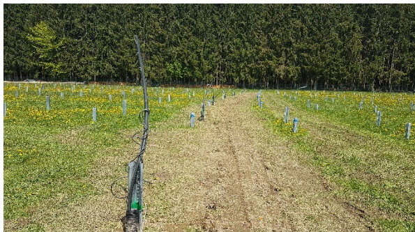
Abbildung 2: Verfüllter Kabelgraben
