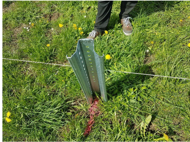
Abbildung 4: Rammfundament
