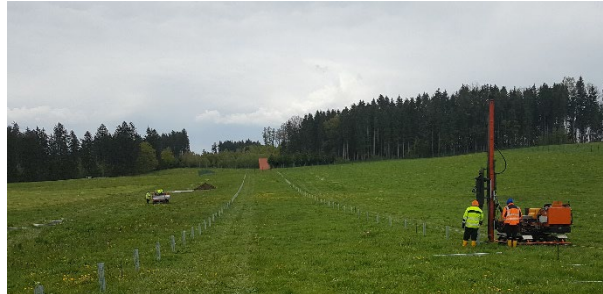
Abbildung 1: Hydraulikramme auf Ketten
